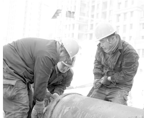
1月17日,天空中飘着雪花,李钦宇和班组的同事们冒着严寒在济河道紫林湾工地上默默地挥洒汗水,他们在忙着断管,打磨断口,安装变径弯头。今天的任务是做路两端勾头,埋设过路管道。李钦宇满身的泥土和脸上浸出的汗水,折射出年轻人的可爱、劳动的可贵。
